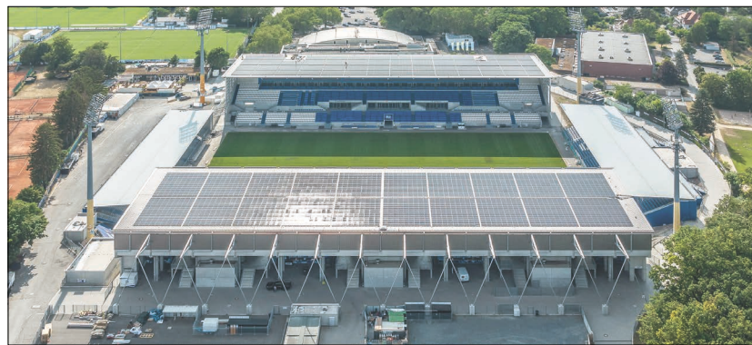
Auf den Dächern der Haupttribüne wurden rund 2.900 PV-Module installiert. Foto: ENTEGA AG
